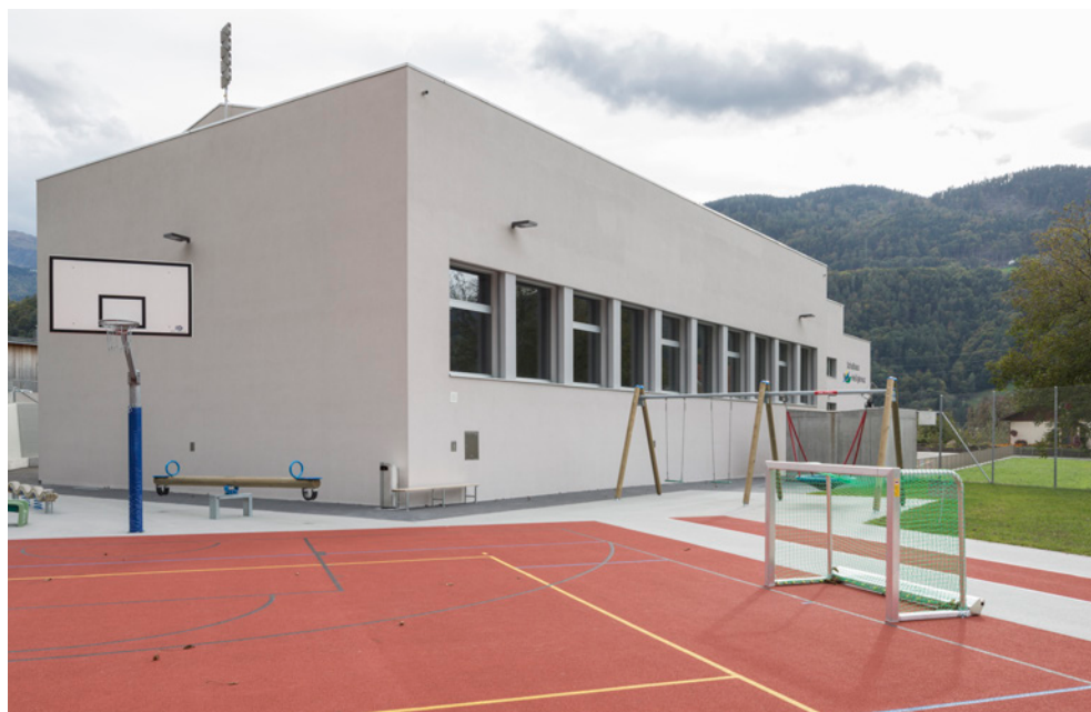
Sanierungsfall: Der Fassadenputz inklusive die darunterliegende Netzeinbettung auf der Fläche der gesamten Westfassade des Schulhauses Heiligkreuz muss erneuert werden.
