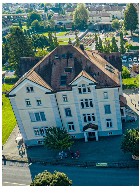
Lohnende Neuerung: Im Schulhaus Dorf wird die veraltete Beleuchtung auf LED umgestellt, was zu einem deutlich geringeren Stromverbrauch führt.
