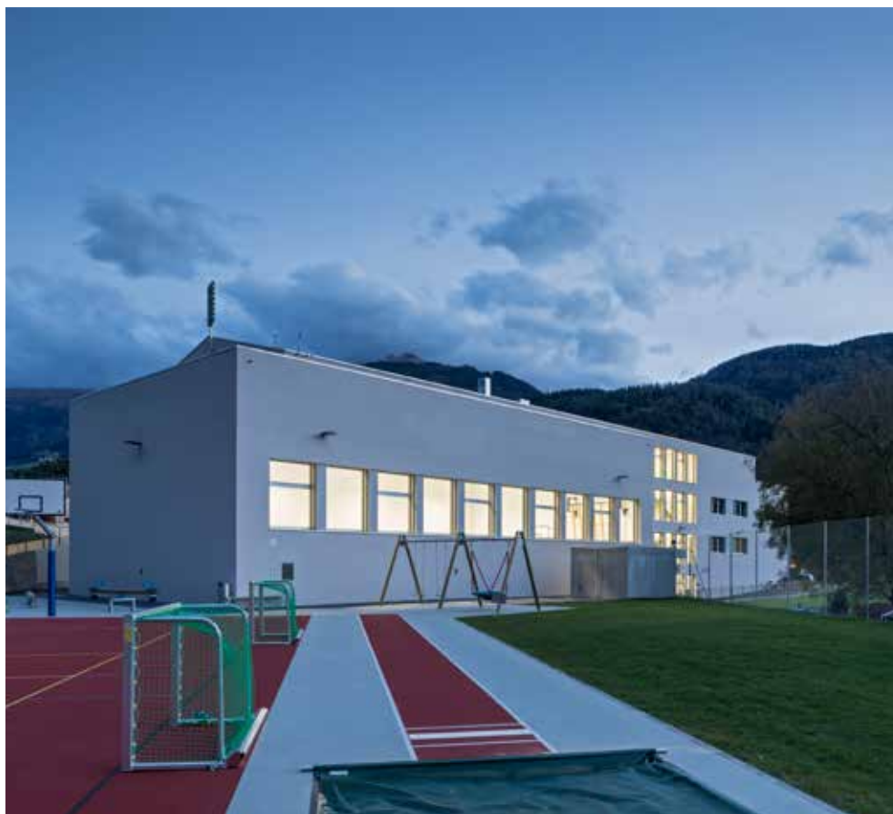
Sanierungsfall: Auch der Auftrag «Storen» im Zusammenhang mit der Fassadensanierung des Schulhauses Heiligkreuz wurde vergeben.
