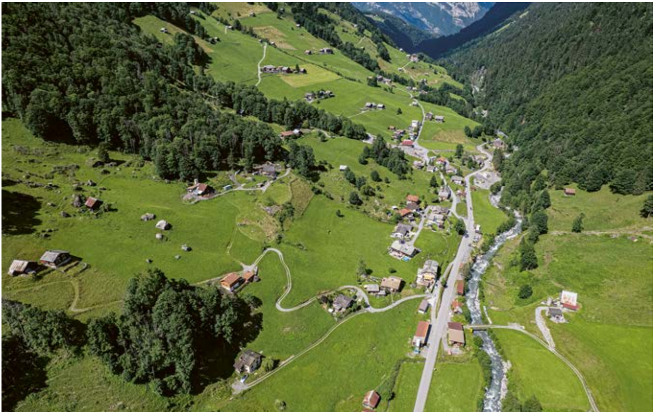
Von Weisstannen via Schwendi (Bild) führt die Abwasserleitung Richtung Langwisen.
