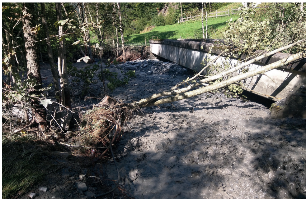
Der «Gufler», ein steter Unruheherd: Am Gufelbach kam es in den letzten Jahren zu einigen Hochwasserereignissen (insbesondere zu vier grösseren Ereignissen in den Jahren 2015 bis 2022). Im Bild die verklebte Brücke nach dem Hochwasser 2022.
