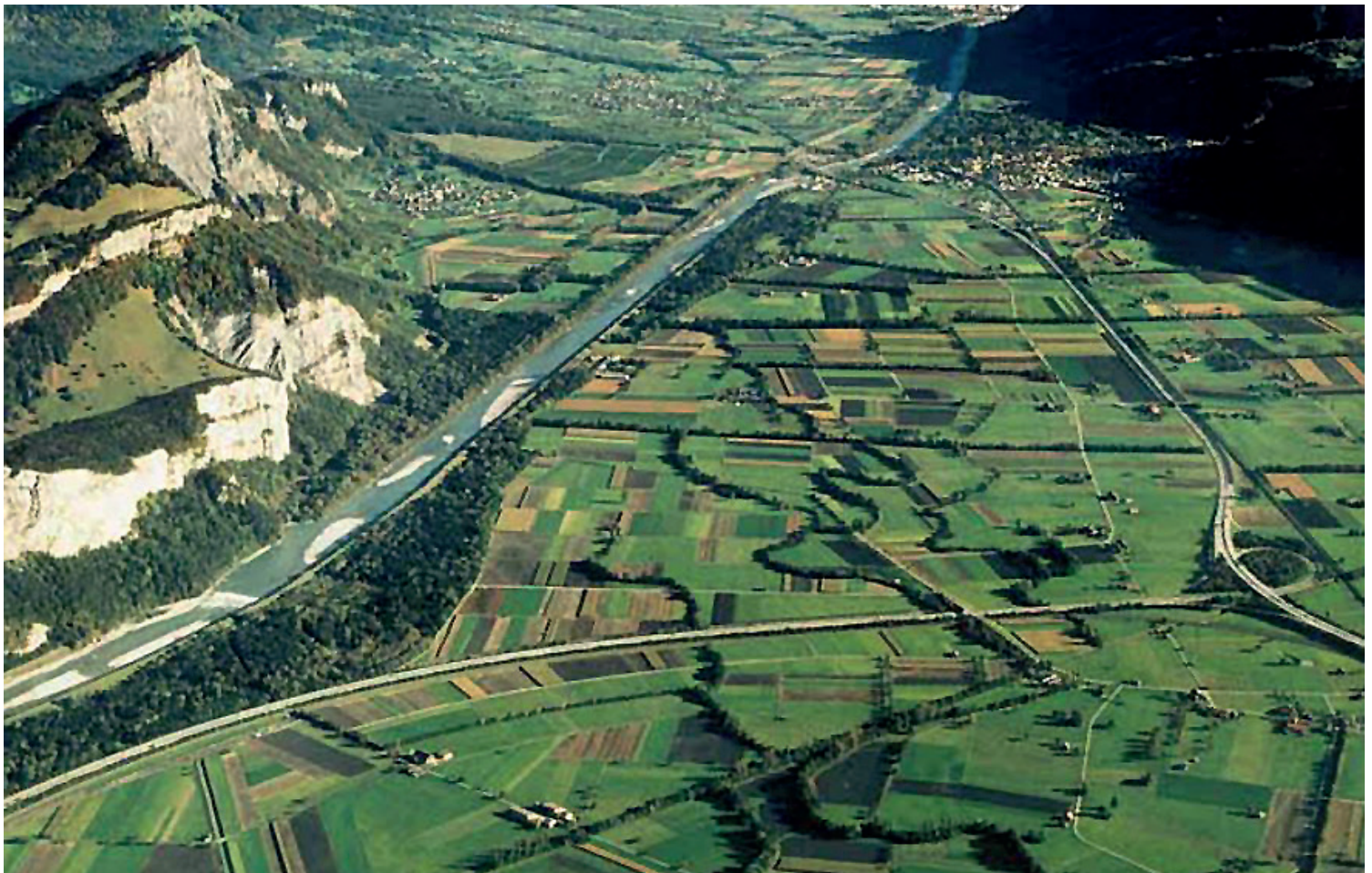
Das Sarganser Becken mit der Melser Ri-Au: Hier befindet sich die grösste Grundwasserreserve des Kantons St. Gallen, ein einmaliges Grundwasservorkommen. Es hat ein Volumen, um bei Bedarf rund 100'000 Personen mit Trinkwasser zu versorgen.
