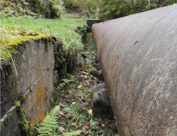
Auf dem Bild links sind Stellen entlang der Druckleitung der KW Stoffel AG ersichtlich, an welchen derzeit keine Winkelstützmauer vorhanden ist. Mit der Erhöhung des Alten Weisstannerweges wird an diesen Stellen ebenfalls eine Winkelstützmauer erstellt und damit die bestehenden Gegebenheiten verbessert.
