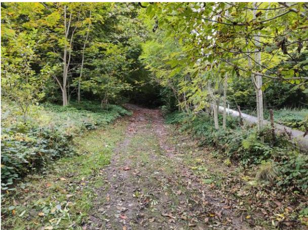
Auf dem Bild links ist die sehr steile Schlüsselstelle ersichtlich. Die Neigung kann flacher gestaltet werden, indem der darunter liegende Strassenverlauf bis max. 1.00m angehoben wird. Die Erhöhung des Alten Weisstannerweges ist auf beiliegendem Längsprofil ersichtlich.
