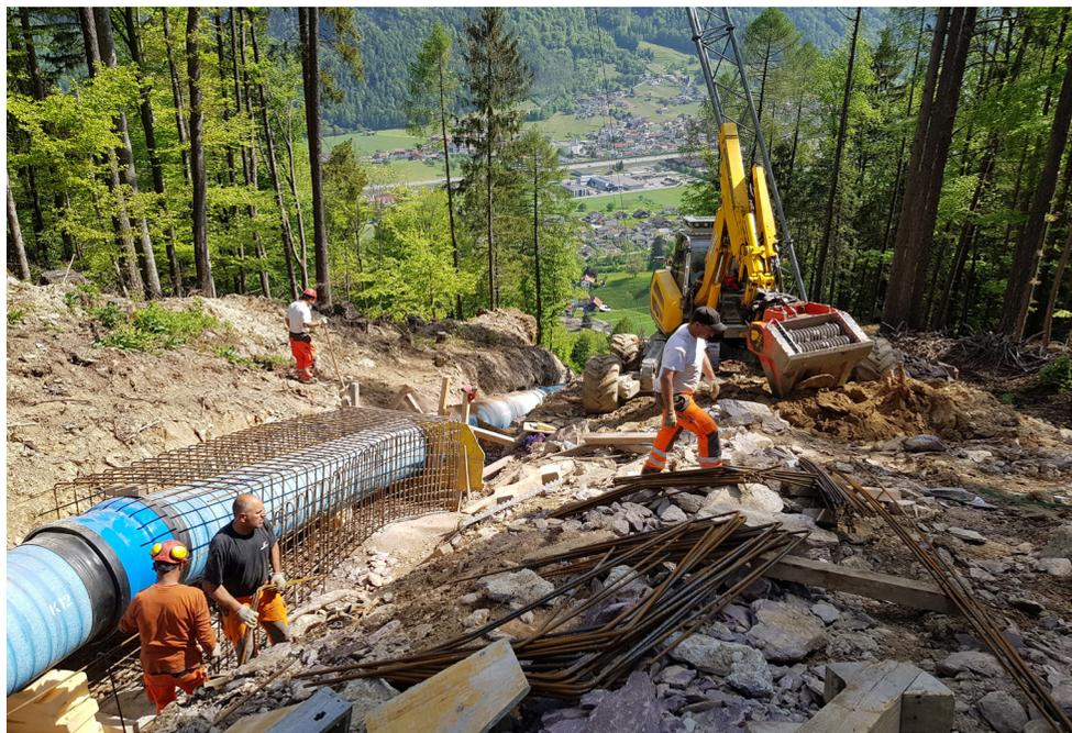
Schadenfall Druckleitung KW Chapfensee-Plons: Die Arbeiten zur Leitungsprüfung sind gestartet.
