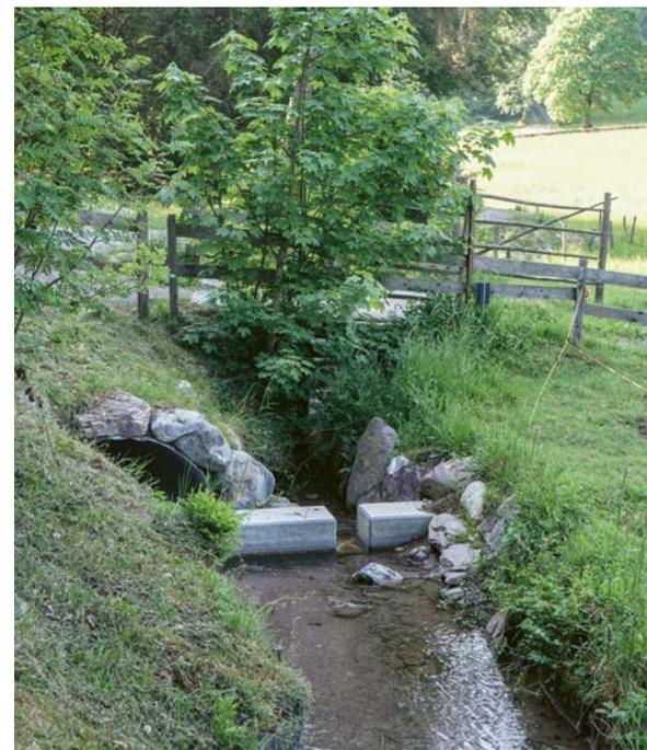
Der Wassertrenner, eine Gabelung, die zwei Drittel des Wassers in die neue Offenlegung (unten) und ein Drittel in den bestehenden Bachlauf leitet.
