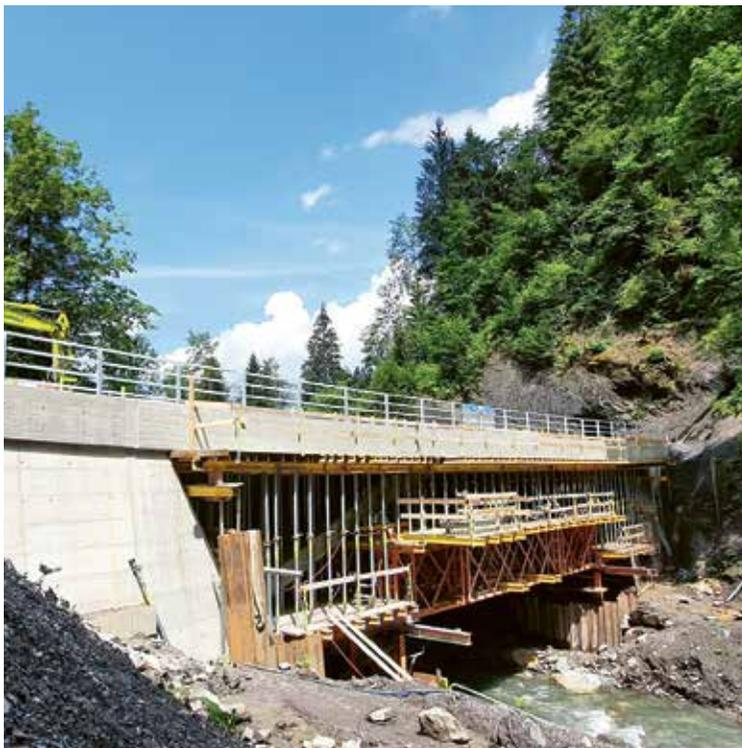
**Neues Tragwerk, neue Fahrbahnplatte: Phase 1 der Sanierung konnte im Sommer abgeschlossen werden.**
