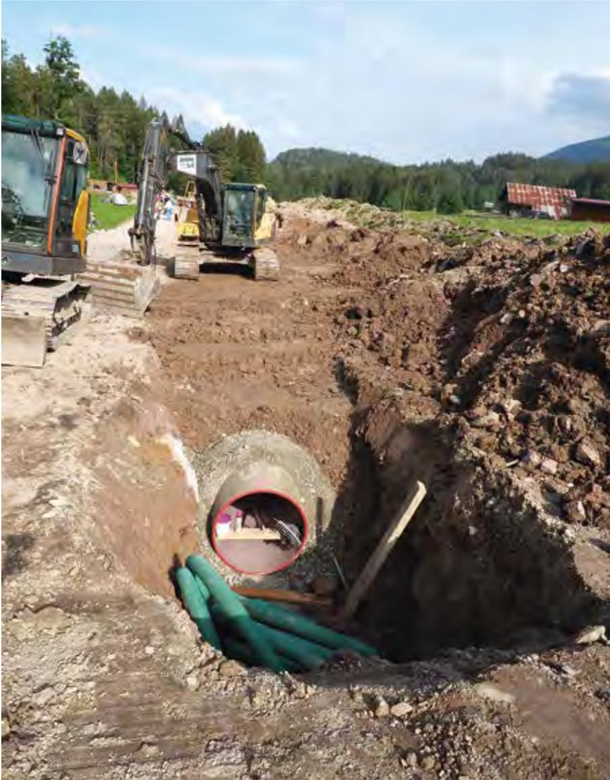
**Imposante Rohre: Die Überleitung vom Kraftwerk Weissenstein zum Kraftwerk Chapfensee (links), sowie Bau und Montage der neuen Druckleitung Plons im Stollen (unten).**
