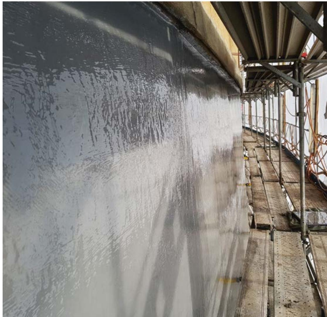
Vorher und nachher: Vor der Sanierung wiesen die Staumauern Löcher auf, in welchen eine Hand Platz hatte, nach der Sanierung wurden sie mit einer Wasser abweisenden Kunststoffschicht überzogen.
