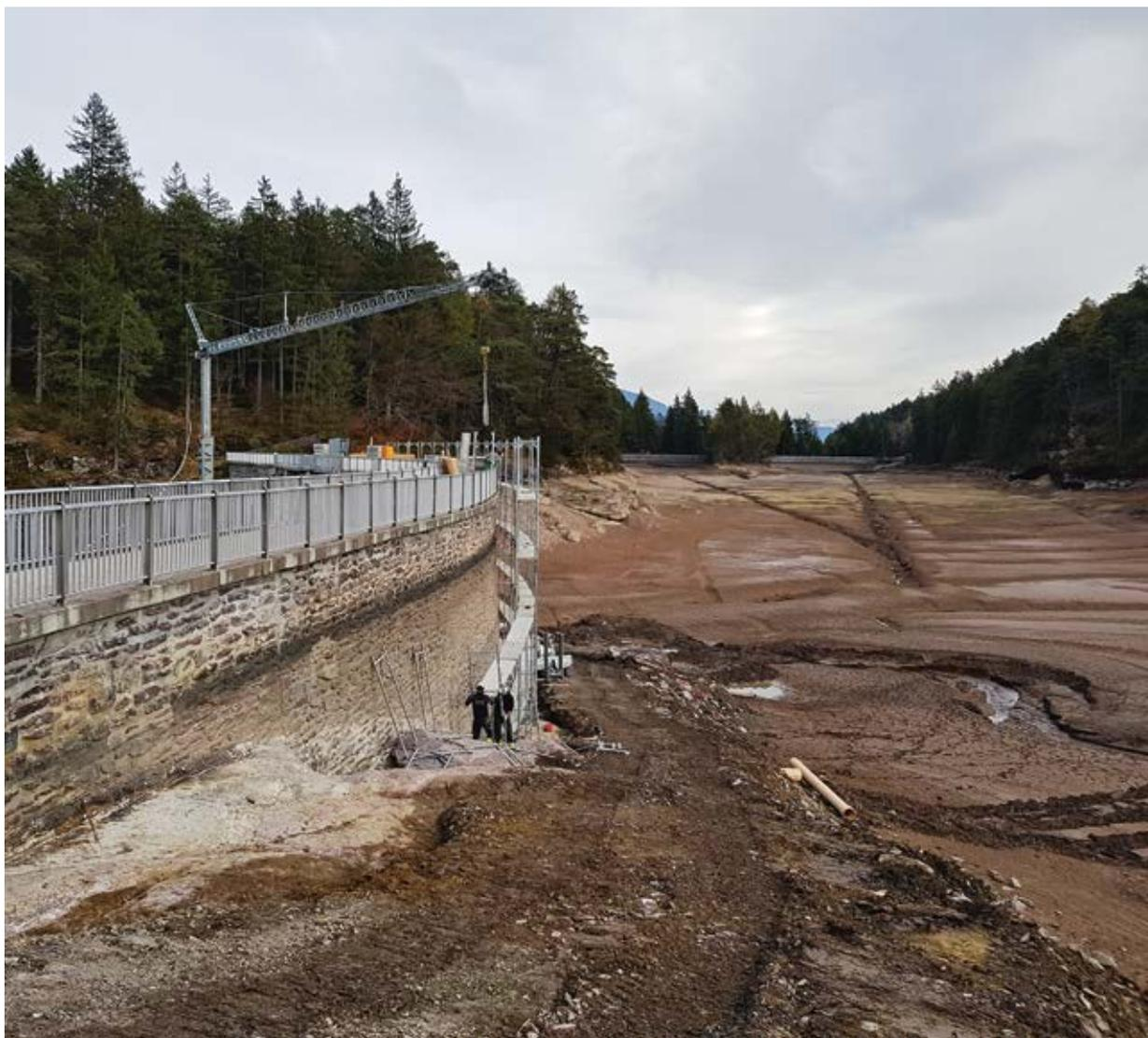
Ein dank KEV-Geldern finanziell sehr gut abgesichertes Grossprojekt: Als Vorbereitung für die Staumauersanierung werden die Fundamente freigelegt und gereinigt.
