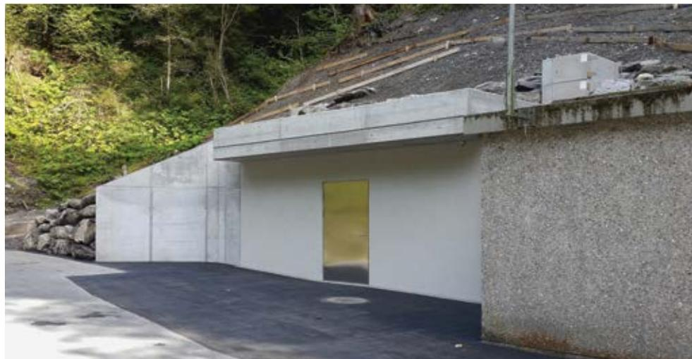
Das Betriebsgebäude im Schattenberg, in welchem die beiden Trinkwasser-Kraftwerkanlagen untergebracht sind, vor einem umfangreich gesicherten Hang.
