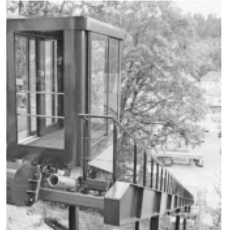
*Hilfreich: Auf einer Fahrbahnlänge von 50 Metern wird eine Höhendifferenz von 31 Metern überwunden werden.*
